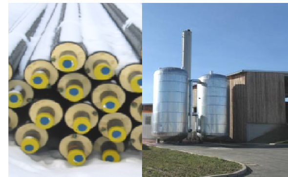
Zwei 50 m 3 Wärmespeicher, 5,5 km Nahwärmenetz für 145 Haushalte
