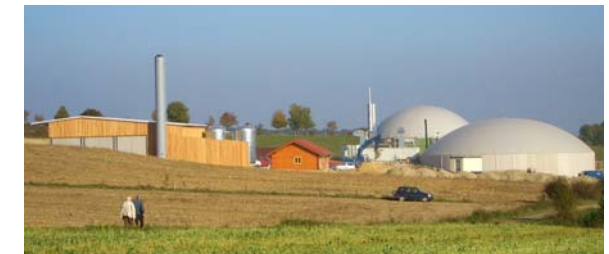
Bioenergieanlage in Jühnde
